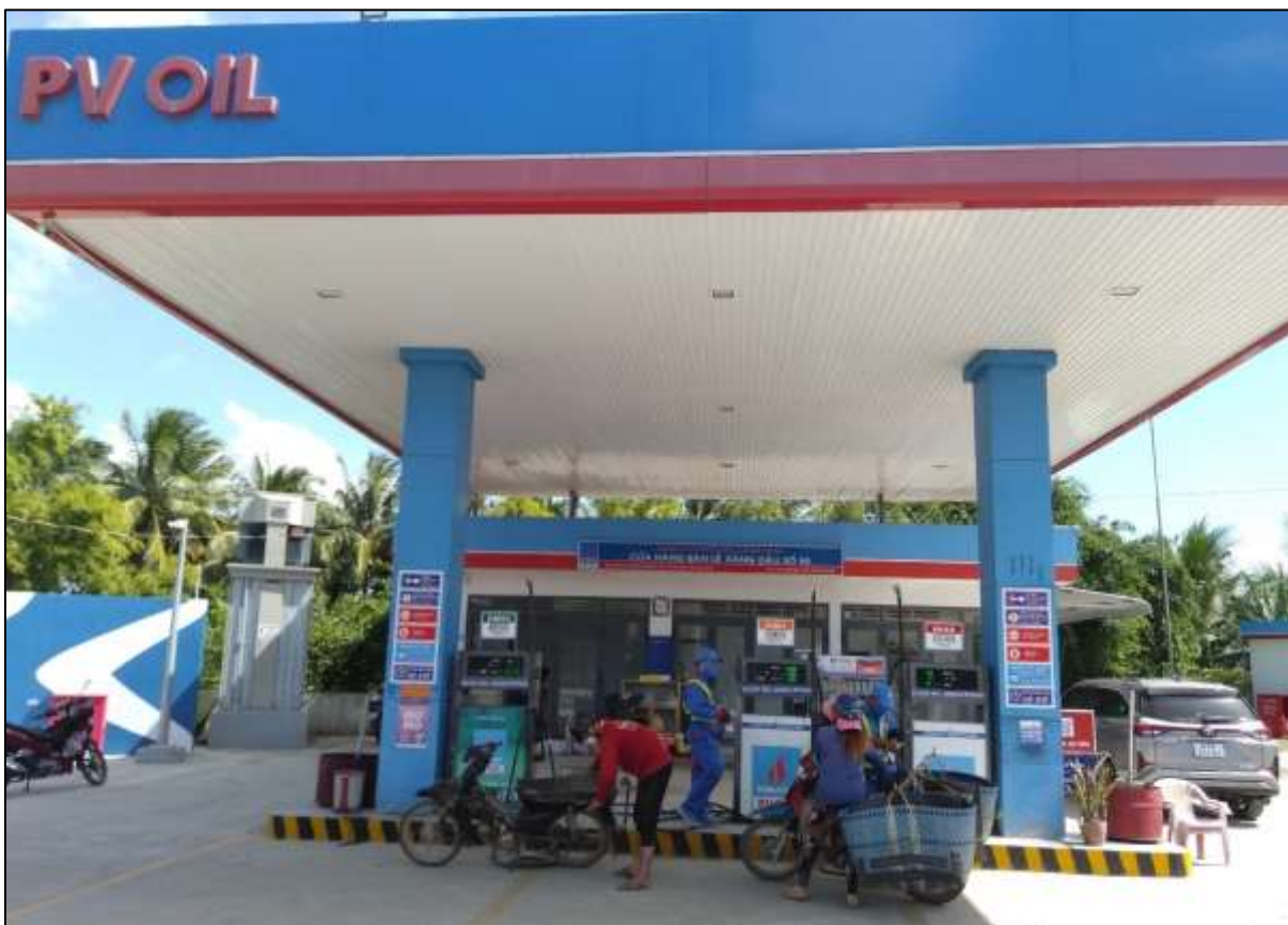
Hình 1.2. Nhà che trụ bơm xăng dầu
